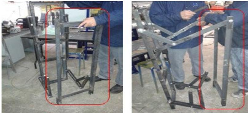
Fig. 2. Armado del mecanismo de elevación.
